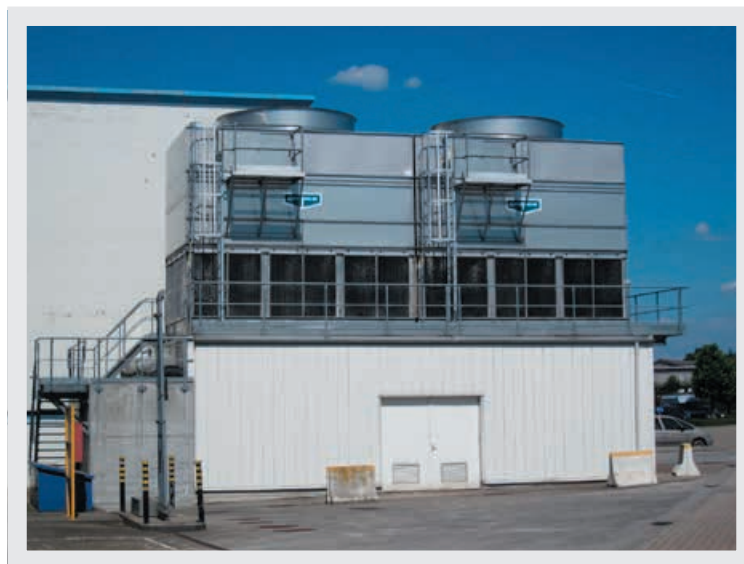
➤ Hoogrendementskoeltoren
