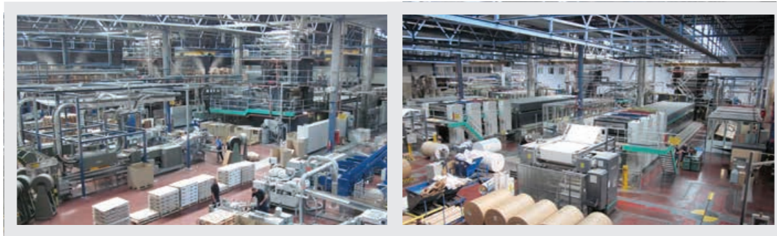
➤ Le déballage des nouvelles rotatives vu d'en haut ➤ Le changeur de bobine des nouveaux rotatives vu d'en haut
